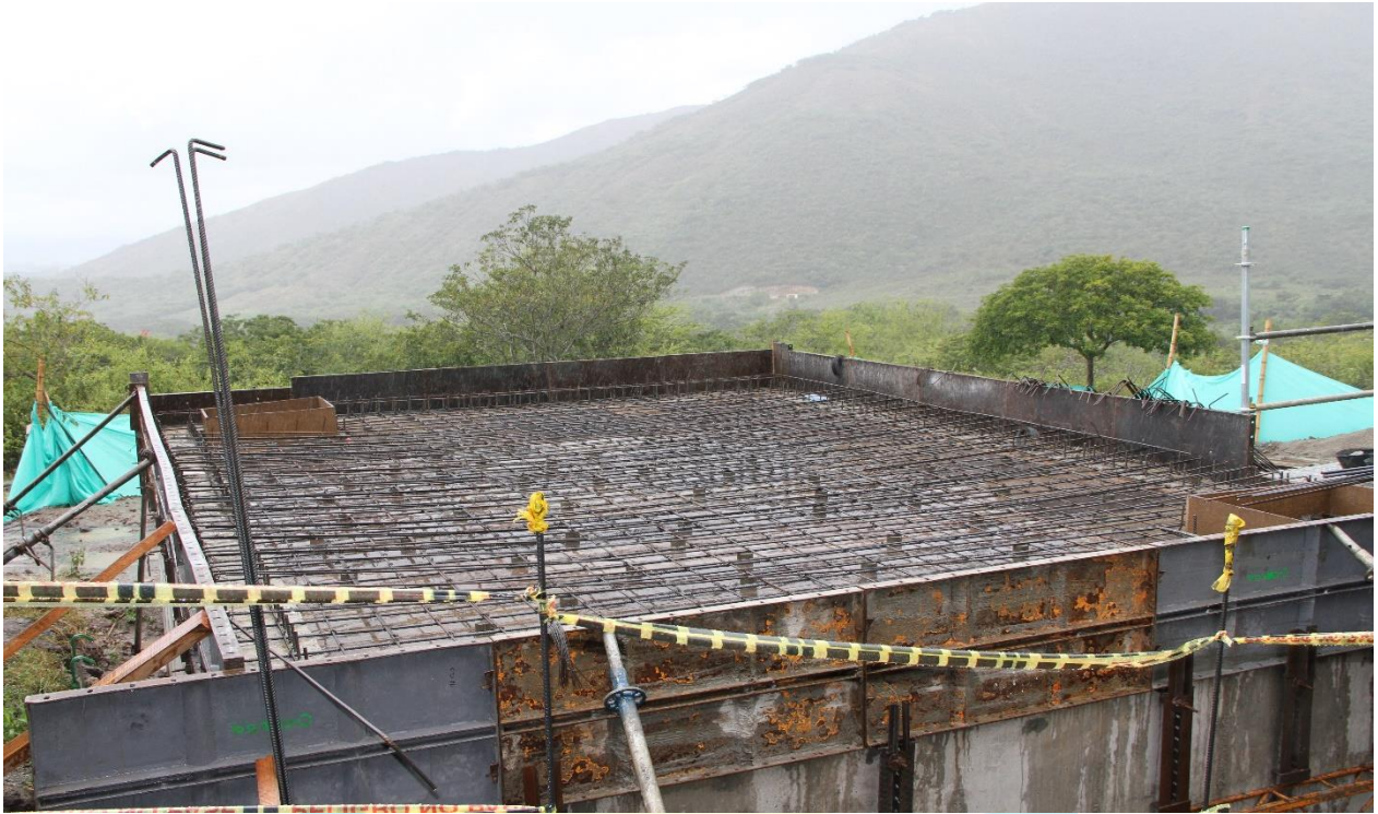
Foto /Vallecaucana de Aguas-Obra de Acueducto, corregimiento La Herradura- Bolívar
